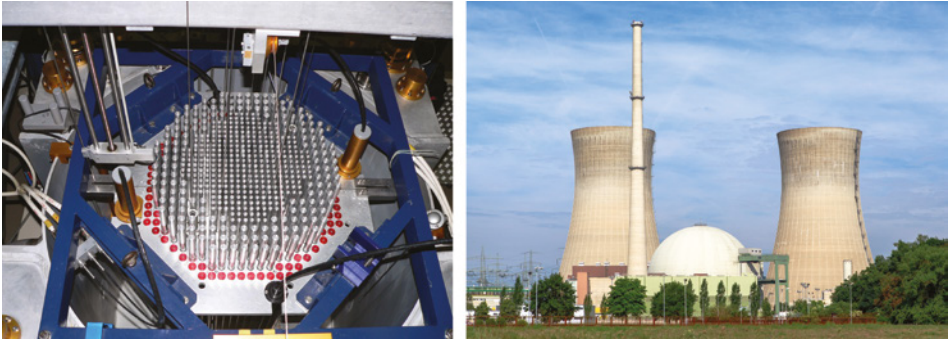
Bild 2.5 Links ist der Versuchs-Kernreaktor mit Brennstäben an der Schweizer EPFL zu sehen und rechts das Kernkraftwerk Grafenrheinfeld mit zwei Kühltürmen und einer Betonkuppel, unter der sich der eigentliche Kernreaktor befindet. Der hohe Schornstein ist vermutlich für die mit Gas oder Diesel betriebenen Notstromaggregate (© links: Wikimedia Commons, Autor: Rama, https://commons.wikimedia.org/wiki/File:Crocus-p1_020_491.jpg , rechts: Wikimedia Commons, Autor: Avda, https://commons.wikimedia.org/wiki/File:Kernkraftwerk_Grafenrheinfeld_-_2013.jpg ).
