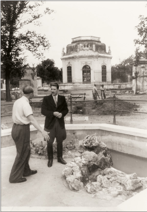
Der Direktor des Tiergartens Schönbrunn, Dr. Julius Brachetka (1916–2011), bei einer Baustellenbesichtigung, im Hintergrund der Kaiserpavillon.
