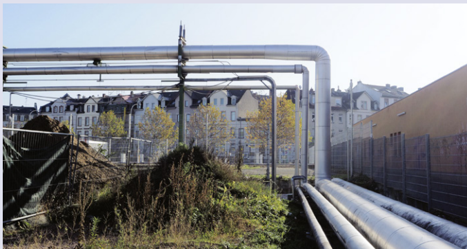
Bild 2.2 Fernwärmenetz in Darmstadt
