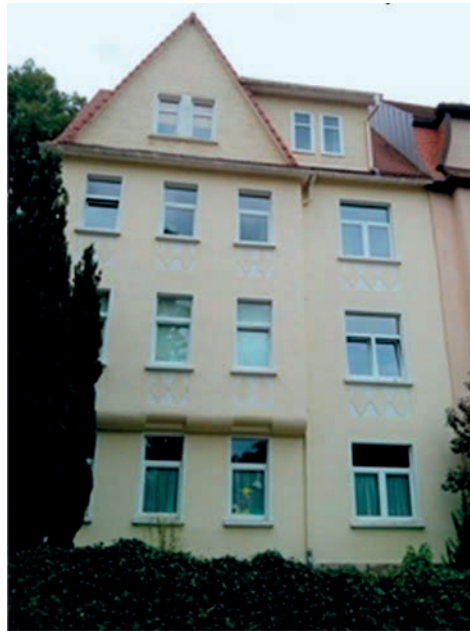
Abb. 33: An der Westschule 1 – Vorderansicht (© Inge Behn)
