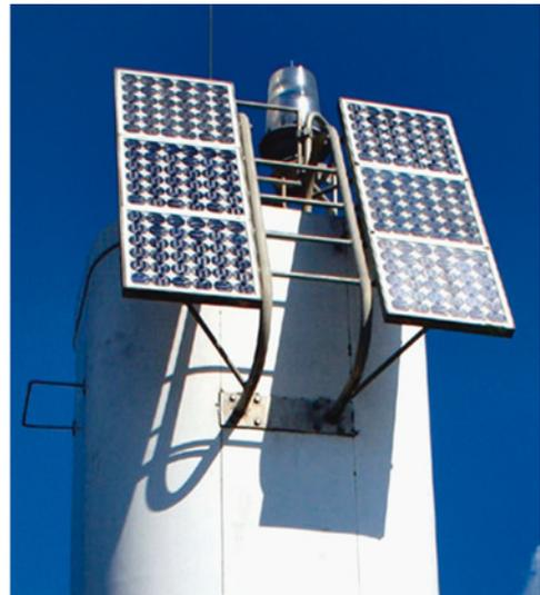
**Bild 1.15** Beispiele für photovoltaische Inselanlagen: Telefonverstärker von 1955 mit der legendären Bell Solar Battery und moderner solarbetriebener Leuchtturm in Australien (Fotos: AT&T Archives and History Center, Erika Johnson)
