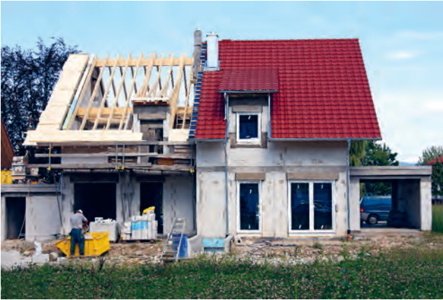
Doppelhaushälften müssen sich nicht unbedingt im gleichen Sanierungszustand befinden.
