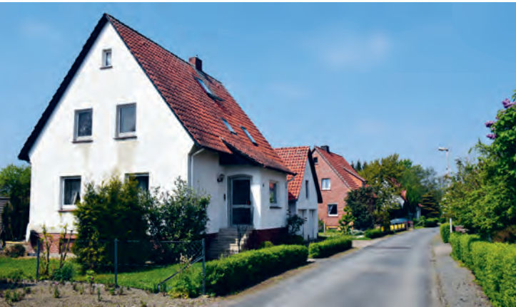
Mangelhaftes Baumaterial macht sich früher oder später negativ bemerkbar.
