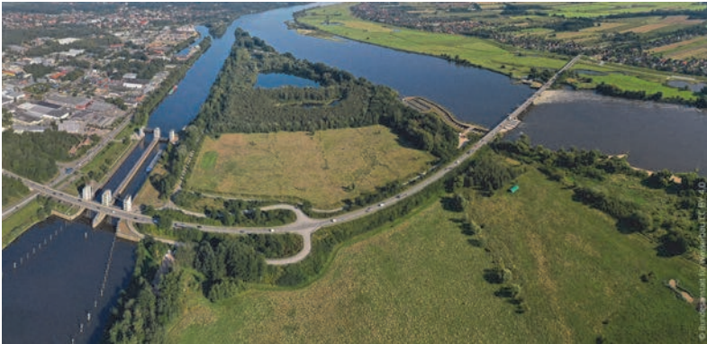
Abbildung 1: Als fiktive Maßnahme zur Sanierung der Elbsedimente wurde ein Wehr mit Stauraum (Sedimentationsbecken) gewählt, in dem sich die in der Elbe mitgeführten, schadstoffbelasteten Schwebstoffe absetzen und dann entnommen, aufbereitet und deponiert werden können. Das Bauwerk könnte dem Wehr und seinen Schleusen in Geesthacht ähneln (hier Luftbild). Hier zu sehen: links Schleusenkanal mit Doppelkammer, rechts Wehr mit vier Wehrverschlüssen und Fischtreppe, Quelle: Bundesanstalt für Wasserbau
