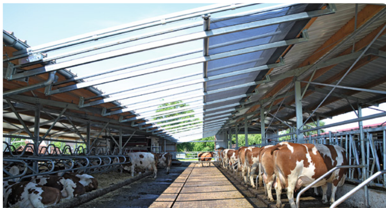
Abb. 4: Mehrhäusiger Sensorgesteuerte Schattierungsanlage sorgt für schattige Fressplätze beim mehrhäusig gebauten Stall
