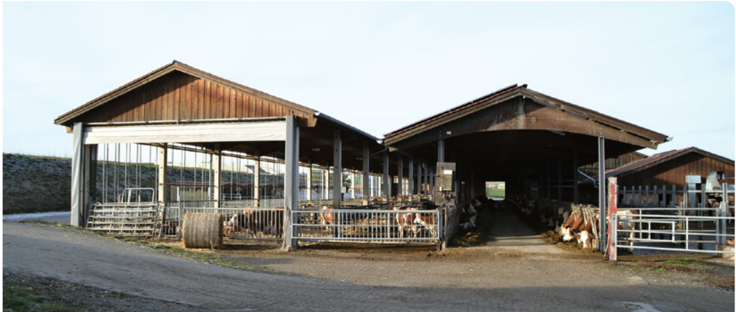
Abb. 3: Mehrhäusiger Laufstall mit integriertem Freigeländezugang im Fressbereich
