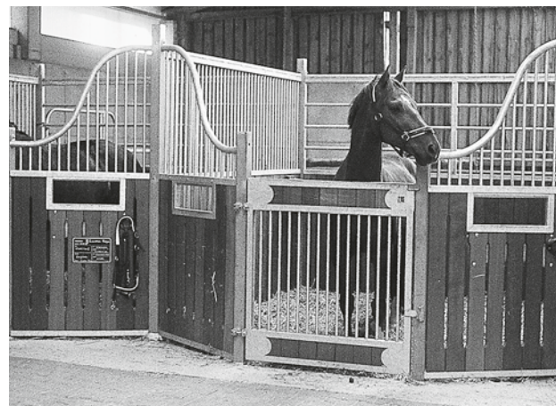
Abb. 20 (oben rechts): Vorderfront der Boxen mit horizontaler Vergitterung. Untere Hälfte der vorderen Abtrennung mit Lüftungsschlitzen.
