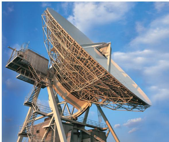
**Bild 1.2.7:** Große (30 m) S-Band-Antenne der DLR-Bodenstation Weilheim (Bild: DLR).
