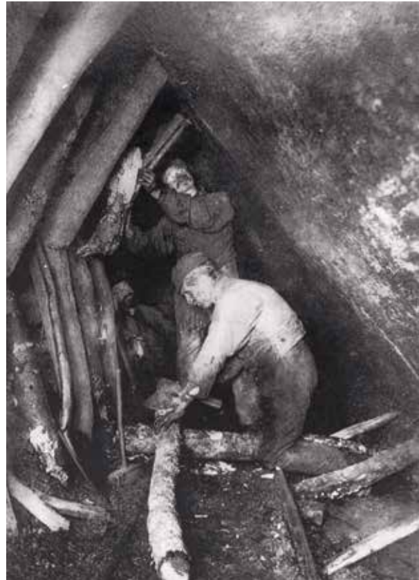
Reparatur-Zimmerhauer im Streckenbau, Zeche Blankenburg, Magnesium-Moment-Photografie von Fr. Schätzke in Bochum, o. D., Papierabzug, s-w.
