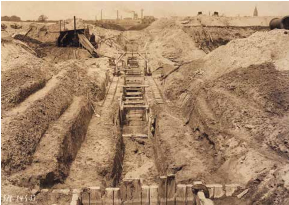
Die Baustelle des Rhein-Herne-Kanals. Die Bauarbeiten und Baustellen dokumentierte der Ingenieur Martin Albrecht. Martin Albrecht, Bildarchiv Stadt Herne.
