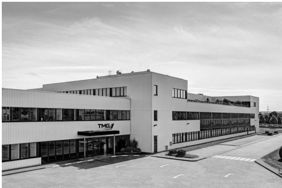
Abbildung 3 - TMG-Hauptgebäude in Köln-Marsdorf
